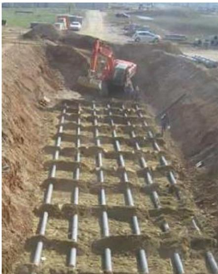
**Mise en œuvre du puits canadien** : 2 nappes de 6 tubes de 40 ml. Diam. 200 mm . Profondeur : 2,50 m et 1,50 m.
