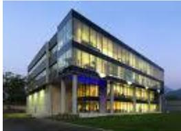
**Forme compacte** du bâtiment ( minimiser l'enveloppe extérieure en contact avec l'air froid ou chaud).
